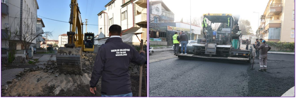
Dilmen Mahallesi 2. Etap Altyapı ve Asfalt Çalışmaları, 2023
