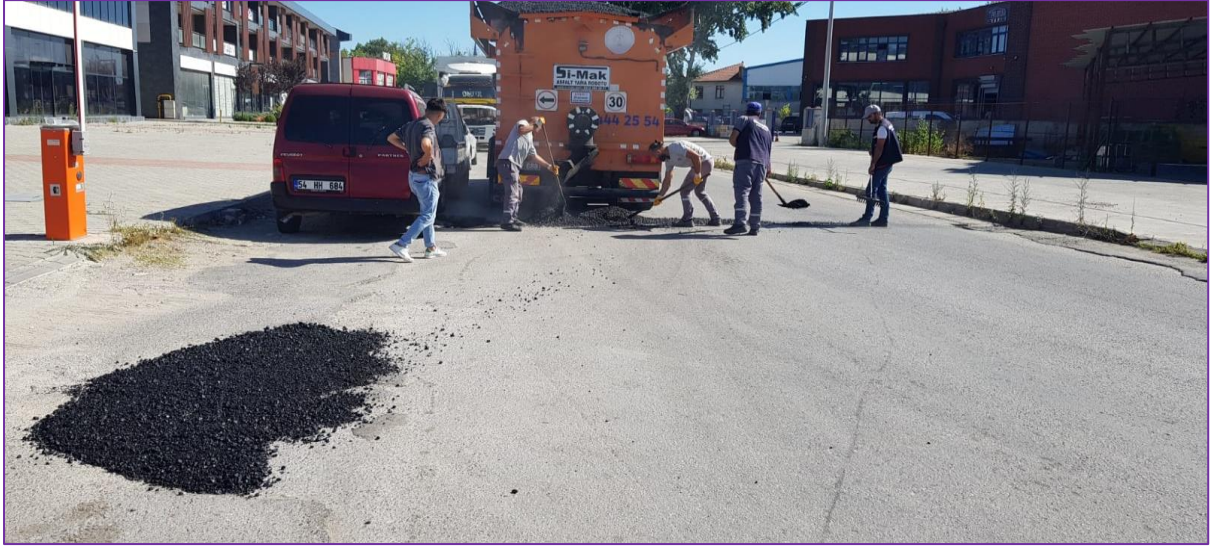
1193 no'lu Sokak Asfalt Yama Çalışması, 2023
