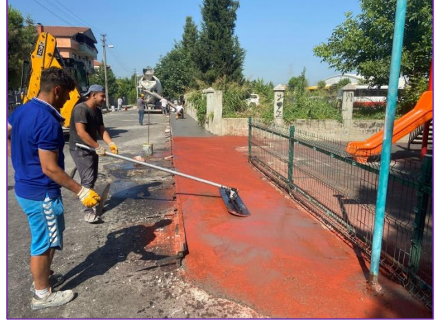
6003 no'lu Sokak Tretuvar Çalışması, 2023
