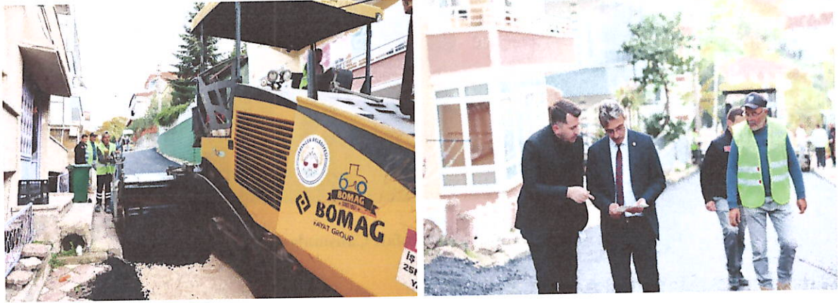
Bağlar Mahallesi Asfalt Çalışmaları
