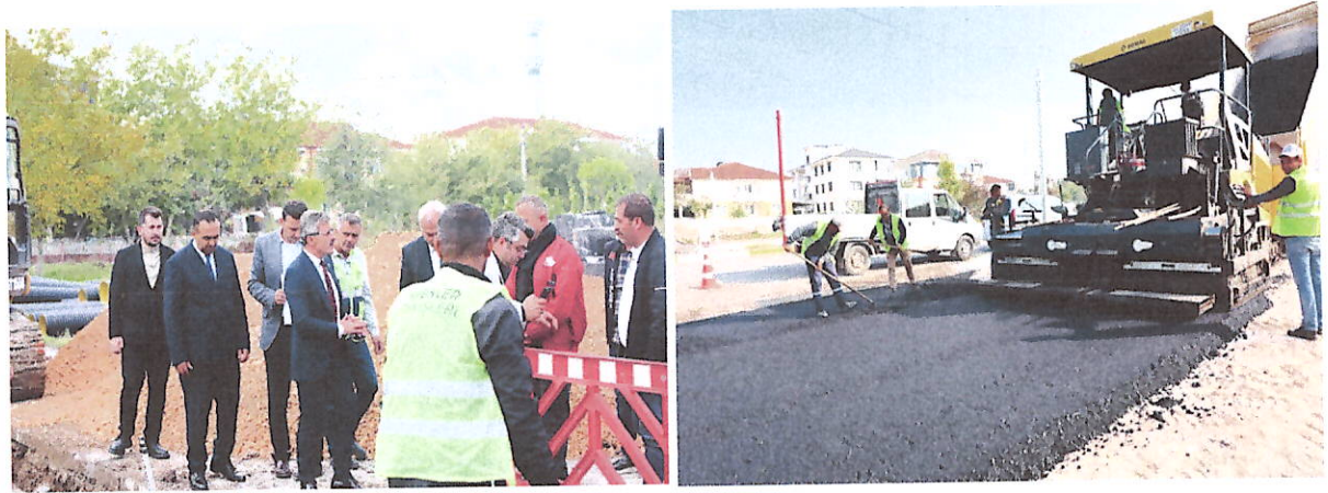
Yeşiltepe Mahallesi Çalışmaları
