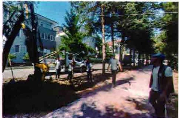
Sağlık Park Yapımı
